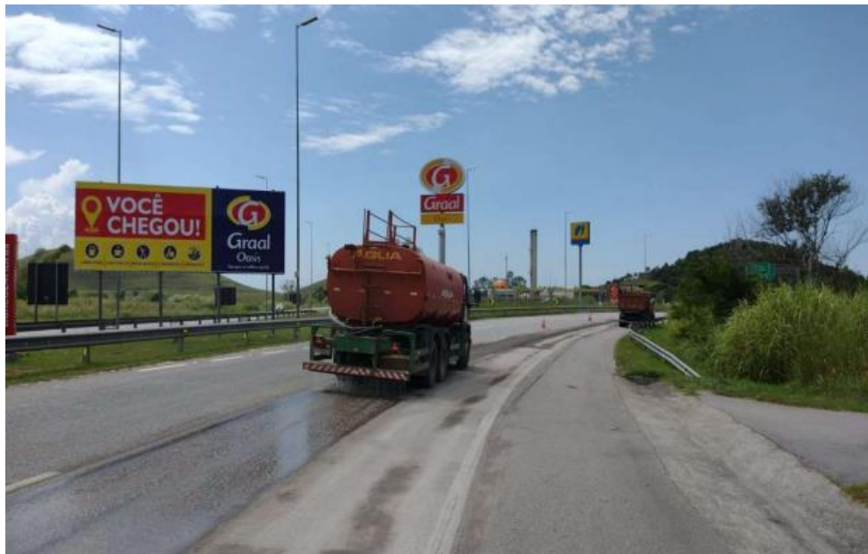
FOTO 10 – Obra Pavimento km 23+000 Norte [3]
