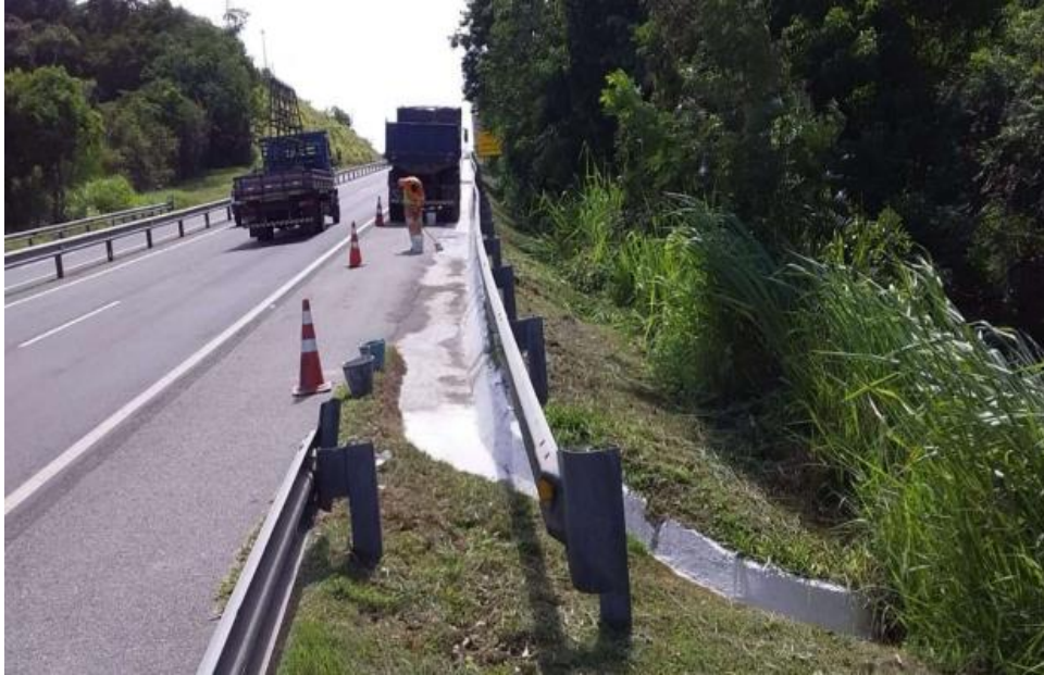
FOTO 03 – Reparo de Sarjeta - Km 25+000 Sul
