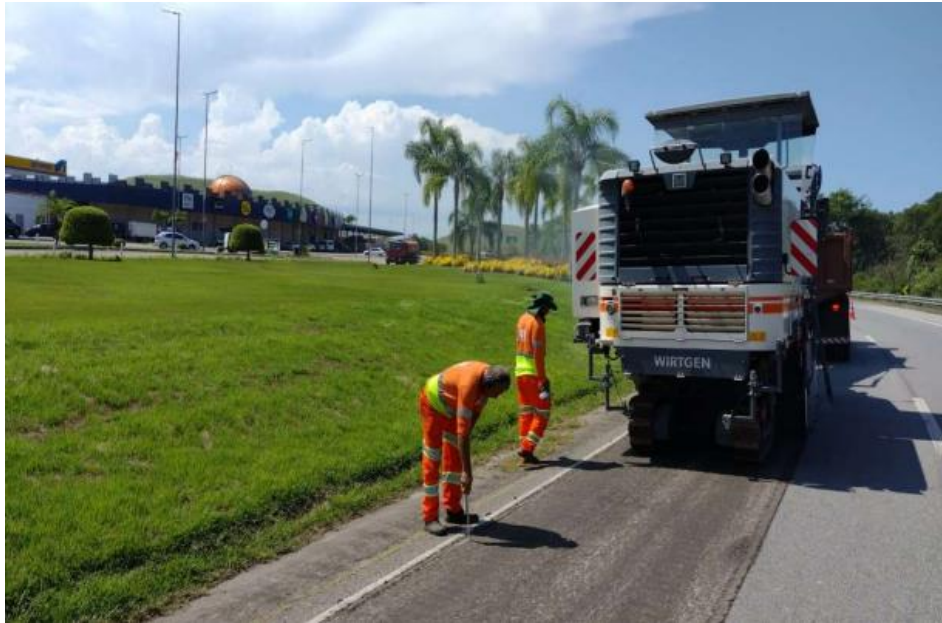
FOTO 09 – Obra Pavimento km 23+000 Norte [2]
