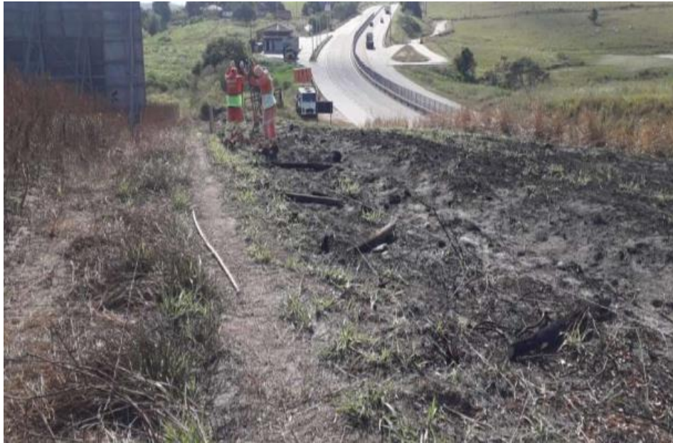
FOTO 05 – Reparo de Cerca - Km 41+000 Norte
