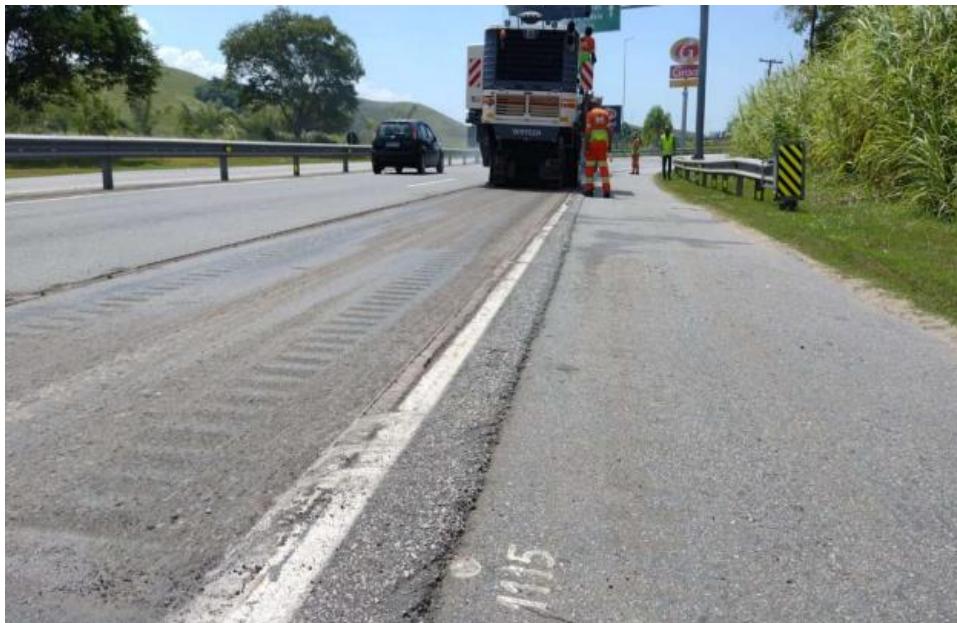
FOTO 08 – Obra Pavimento km 22+000 Norte [1]
