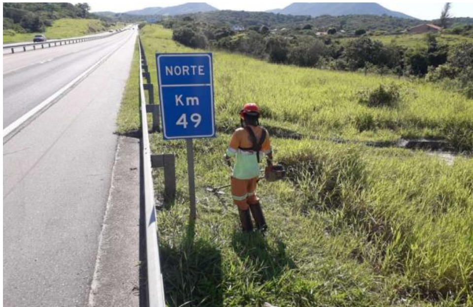
FOTO 04 – Roçada Manual - Km 49+000 Norte
